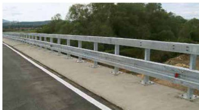
Крепление элементов мостового полотна
