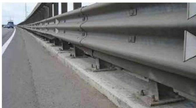
Монтаж стоек барьерного ограждения на мостах и эстакадах (установка большого количества анкерных креплений поточным методом)
