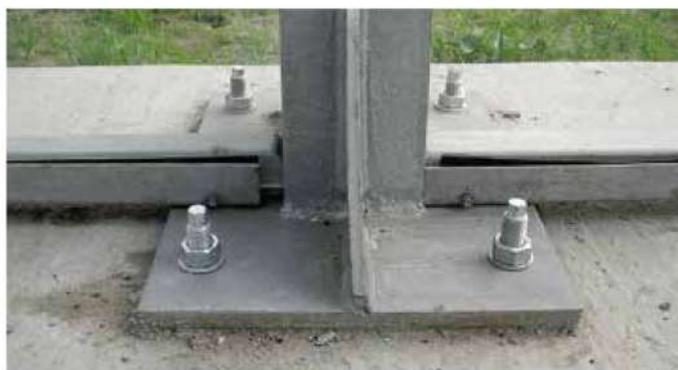
Применение анкер-шпилек из упрочненной стали при динамических воздействиях (крепление стоек шумозащитных экранов)
